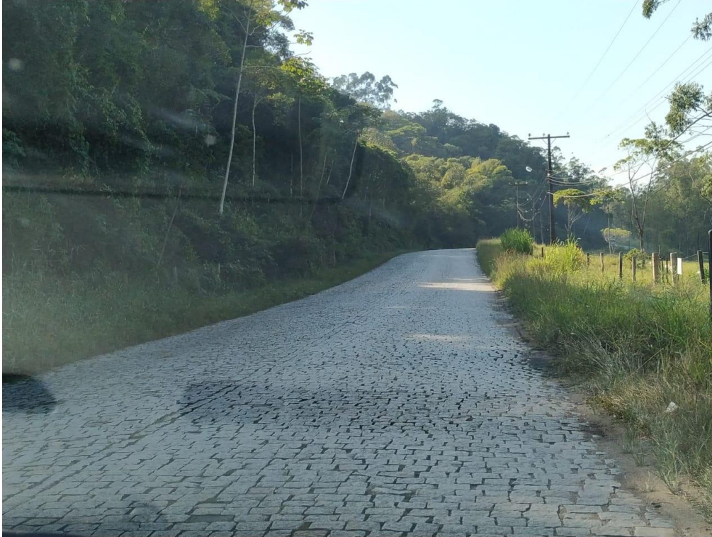
Figura 9 - Via de acesso: Rua José Geraldino Bittencourt
