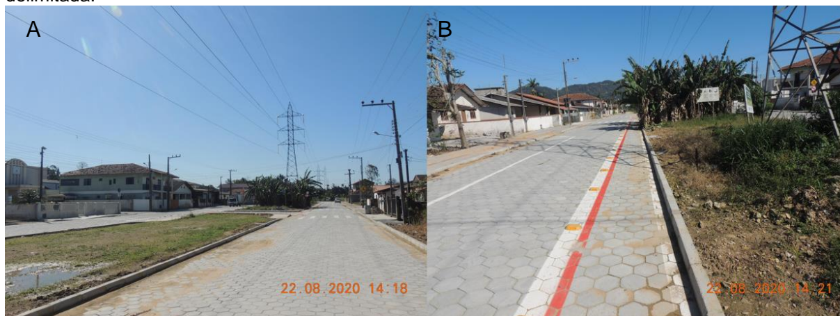
FIGURA 18 – Avenida Padre Carlos Guesser. A) Notar pavimentação com lajotas sextavadas e o canteiro central onde passa a rede de transmissão de altíssima tensão. B) Detalhe da ciclofaixa delimitada.
