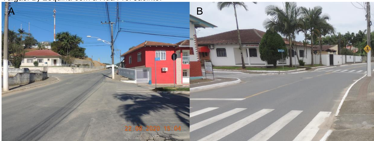
FIGURA 22 – Rua Dr. Leoberto Leal. Notar pavimentação asfáltica. A) Esquina com a Avenida Joleto Vargas. B) Esquina com a Rua Frei Jacinto.
