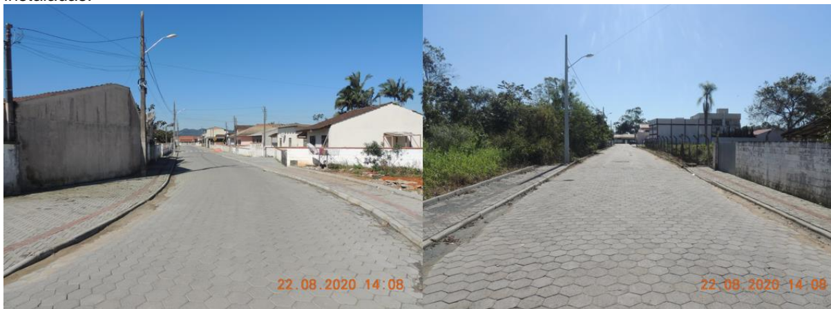
FIGURA 30 – Rua Ricardo Smogel Filho. Notar pavimentação e calçadas com piso tátil recentemente instaladas.
