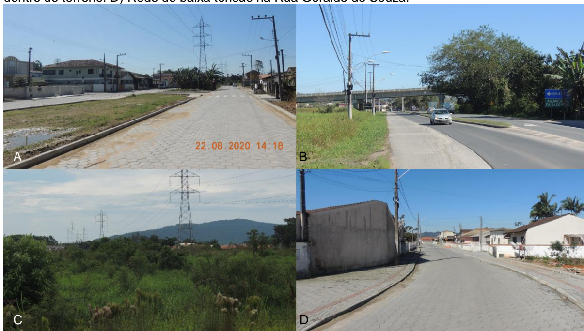
FIGURA 10 – Rede de distribuição de energia elétrica da AID. A) Rede de altíssima, alta e baixa tensão na Avenida Padre Carlos Guessser. B) Rede de alta e baixa tensão na Rodovia SC 412, em frente ao terreno onde se pretende fazer a instalação do loteamento. C) Rede de altíssima tensão que passa dentro do terreno. D) Rede de baixa tensão na Rua Geraldo de Souza.
