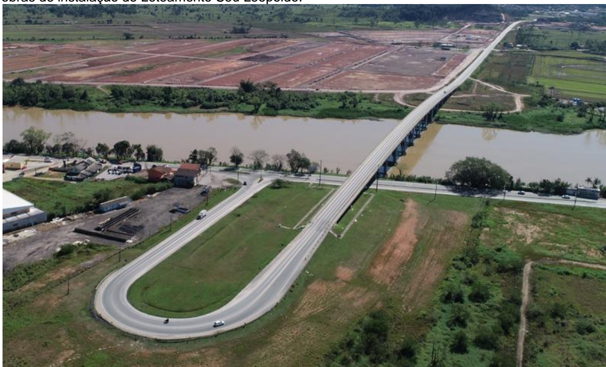
FIGURA 31 – Imagem aérea da Ponte Padre Cláudio Jeremias Cadorin. Ao fundo é possível notar as obras de instalação do Loteamento Seu Leopoldo.
