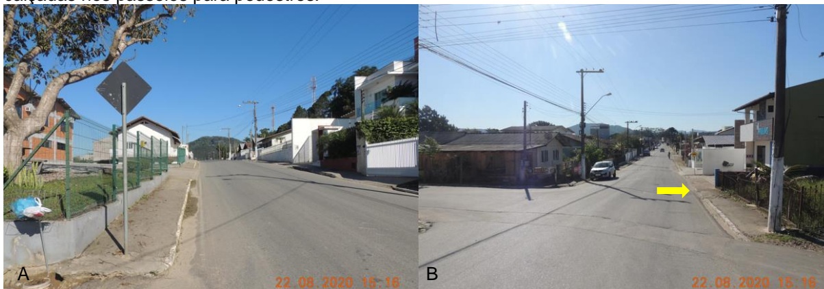
FIGURA 29 – Rua Modesto Vargas. A) Notar pavimentação asfáltica. B) Notar irregularidade de calçadas nos passeios para pedestres.
