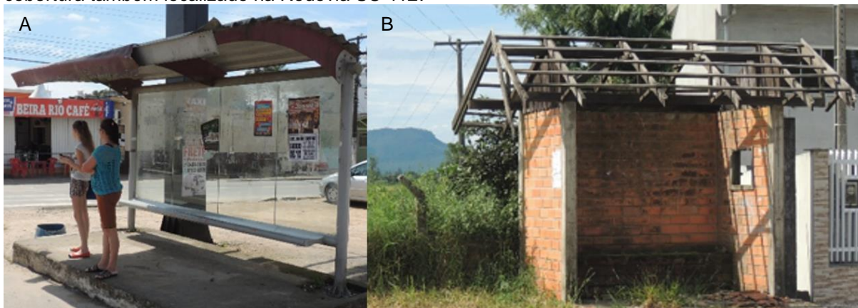
FIGURA 72 – Pontos de ônibus. A) Ponto coberto localizado na Rodovia SC 412. B) Ponto sem cobertura também localizado na Rodovia SC 412.
