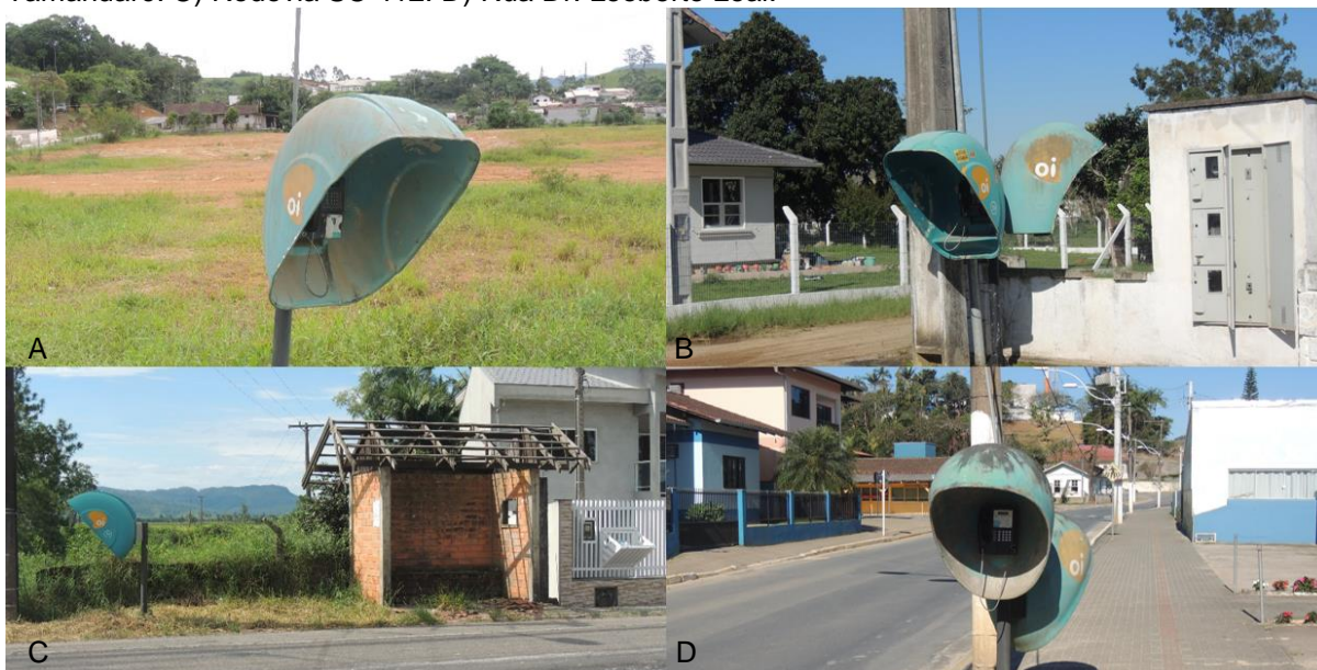
FIGURA 11 – Alguns dos telefones públicos instalados na AID. A) Rua Nilson Lessa. B) Rua Almirante Tamandaré. C) Rodovia SC 412. D) Rua Dr. Leoberto Leal.
