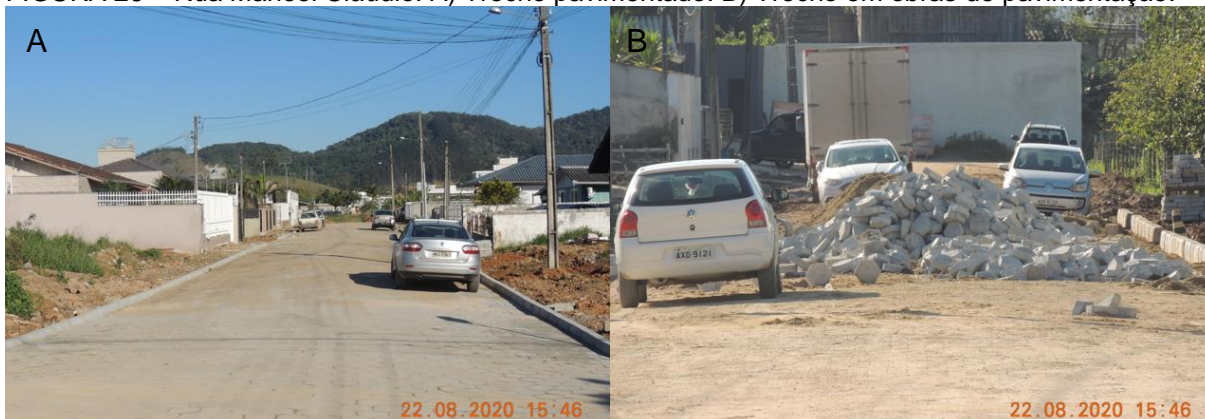
FIGURA 26 – Rua Manoel Cláudio. A) Trecho pavimentado. B) Trecho em obras de pavimentação.
