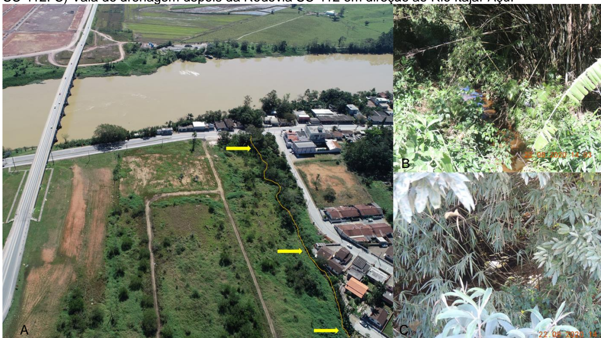
FIGURA 7 – Drenagem pluvial da ADA. A) Imagem aérea ilustrando a vala de drenagem pluvial existente na extremidade Leste do terreno. B) Vala de drenagem antes da passagem sob a Rodovia SC 412. C) Vala de drenagem depois da Rodovia SC 412 em direção ao Rio Itajaí-Açu.
