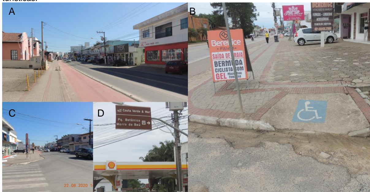
FIGURA 19 – Rodovia SC 412. Notar pavimentação asfáltica. A) Ciclofaixa devidamente pintada e delimitada. B) Rampas de acesso a deficientes físicos e piso tátil. C) Vista geral da SC-412. D) Placas turísticas.
