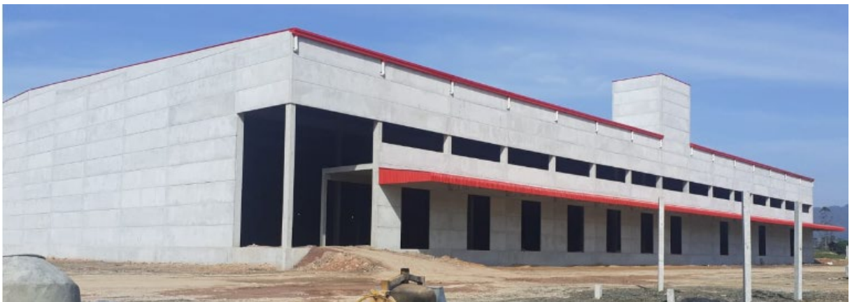
Figura 3 - Vista externa do empreendimento
