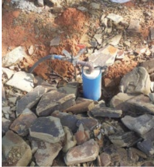
Figura 6 - Poço de captação de água subterrânea
